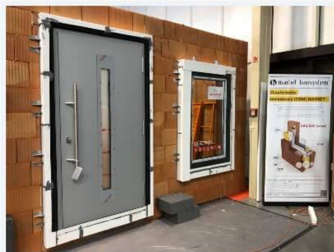
Okno i drzwi wejściowe zamontowane z wykorzystaniem systemu CBM
