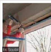
Montaż stolarki – wczoraj i dziś
