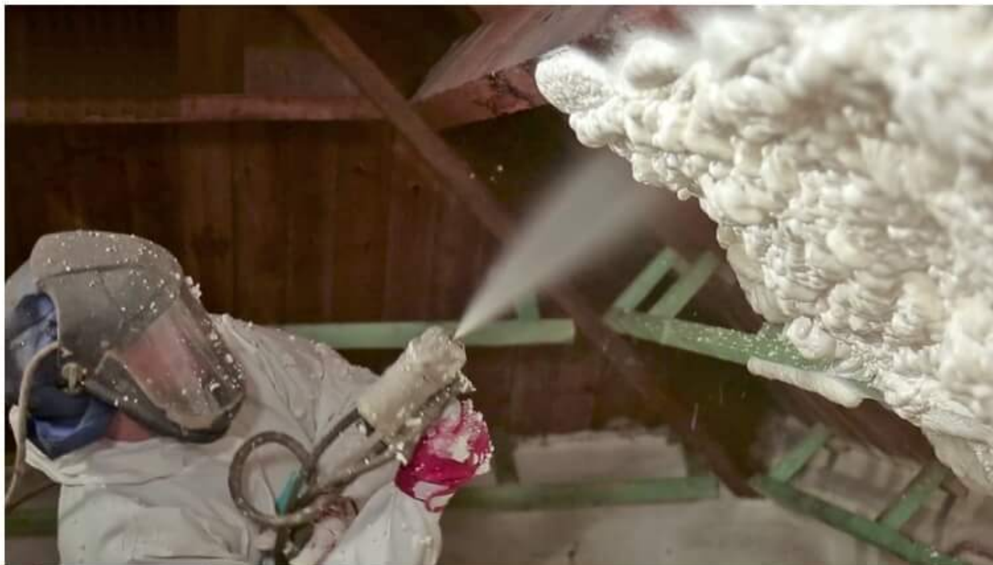
Pianka Soudafoam SPF otwartokomórkowa służy do wykonywania ocieplenia dachu od wewnątrz
