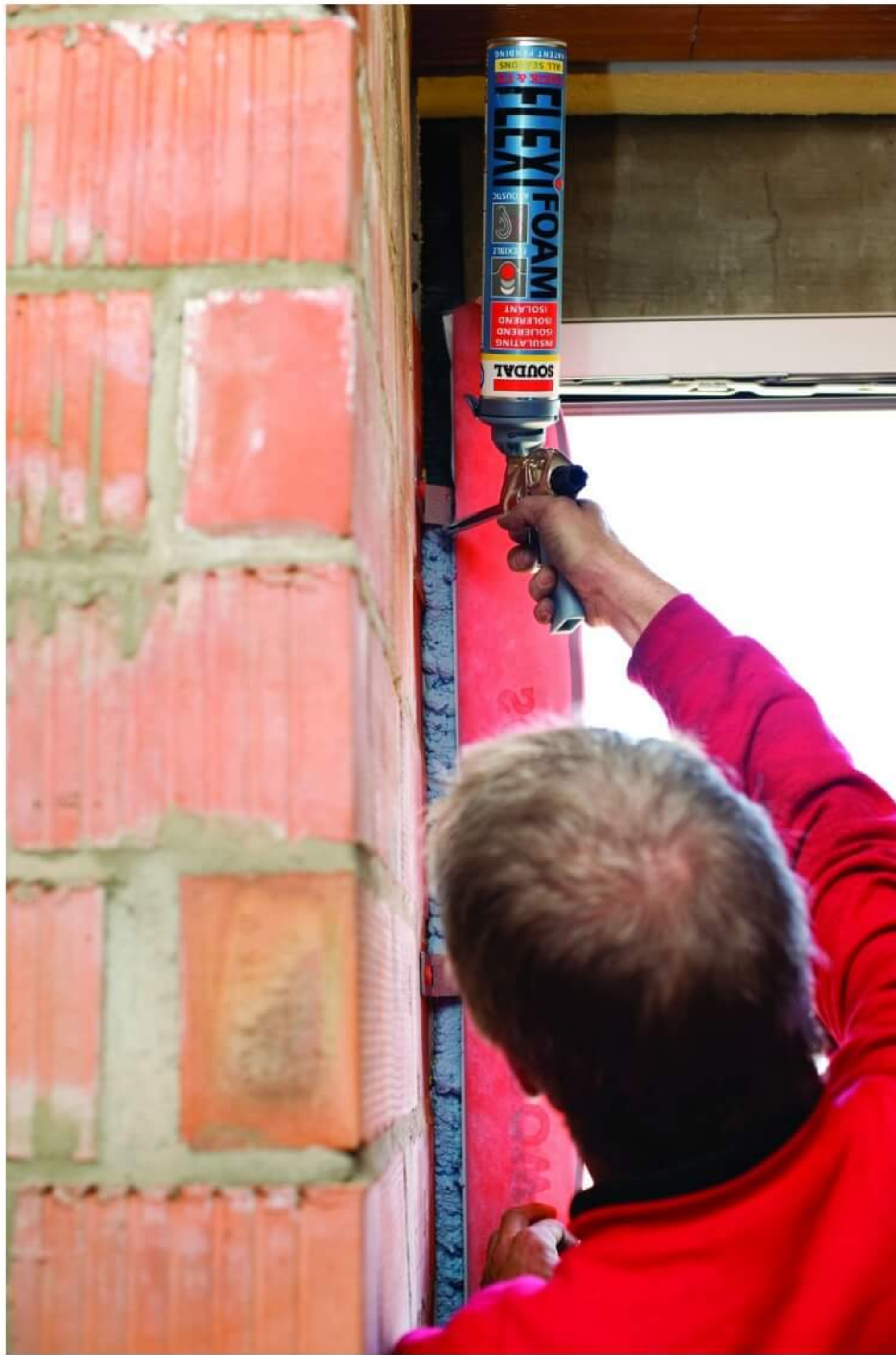
Uszczelnienie miejsc osadzenia okien w ościeżu
