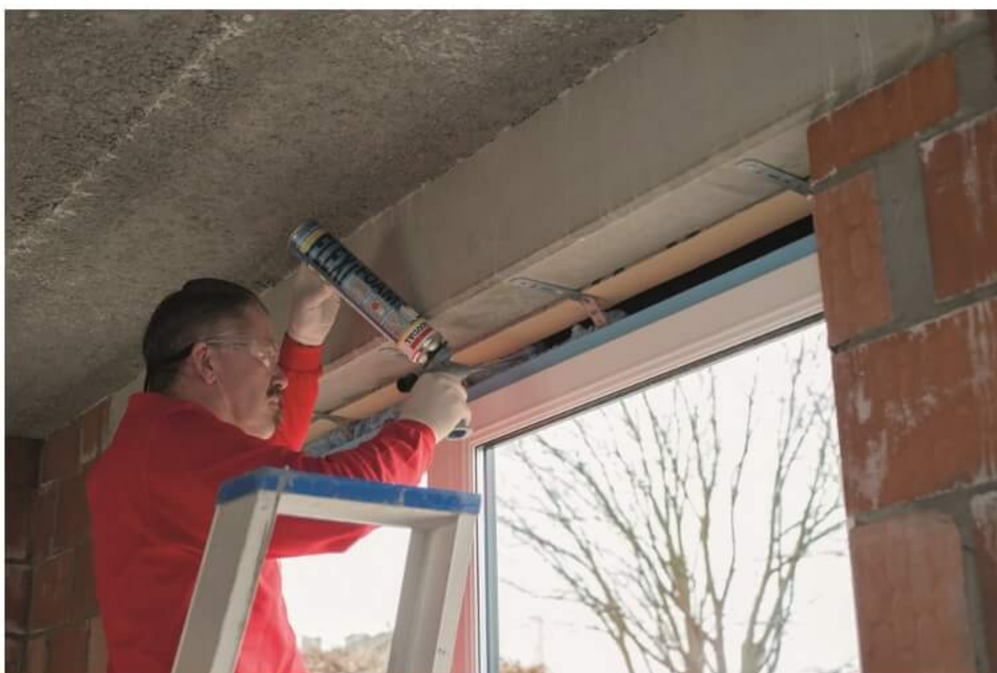
Wykonanie uszczelnienia styku okna z murem
