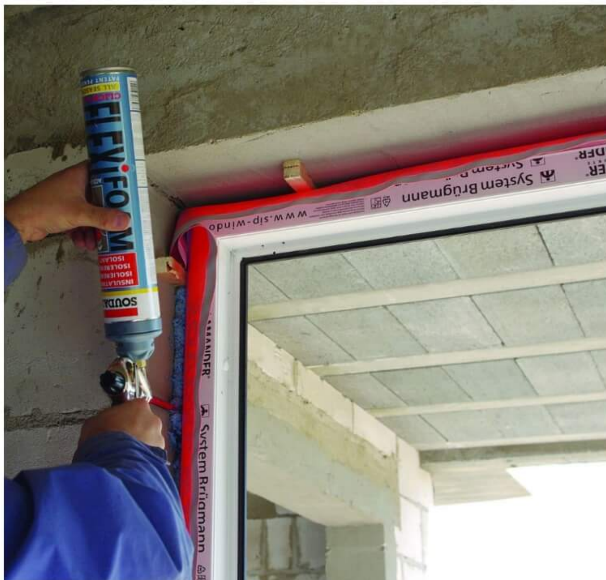
Prace montażowo-uszczelniające przy montażu okna w systemie SWS z wykorzystaniem pianki Flexifoam. fot. Soudal
