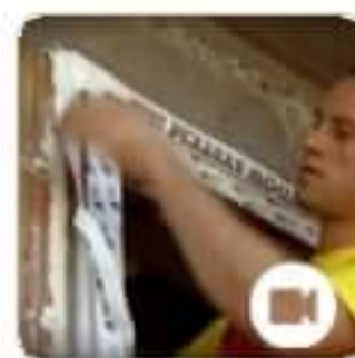
Ciepły montaż OknoPlus z Soudal
