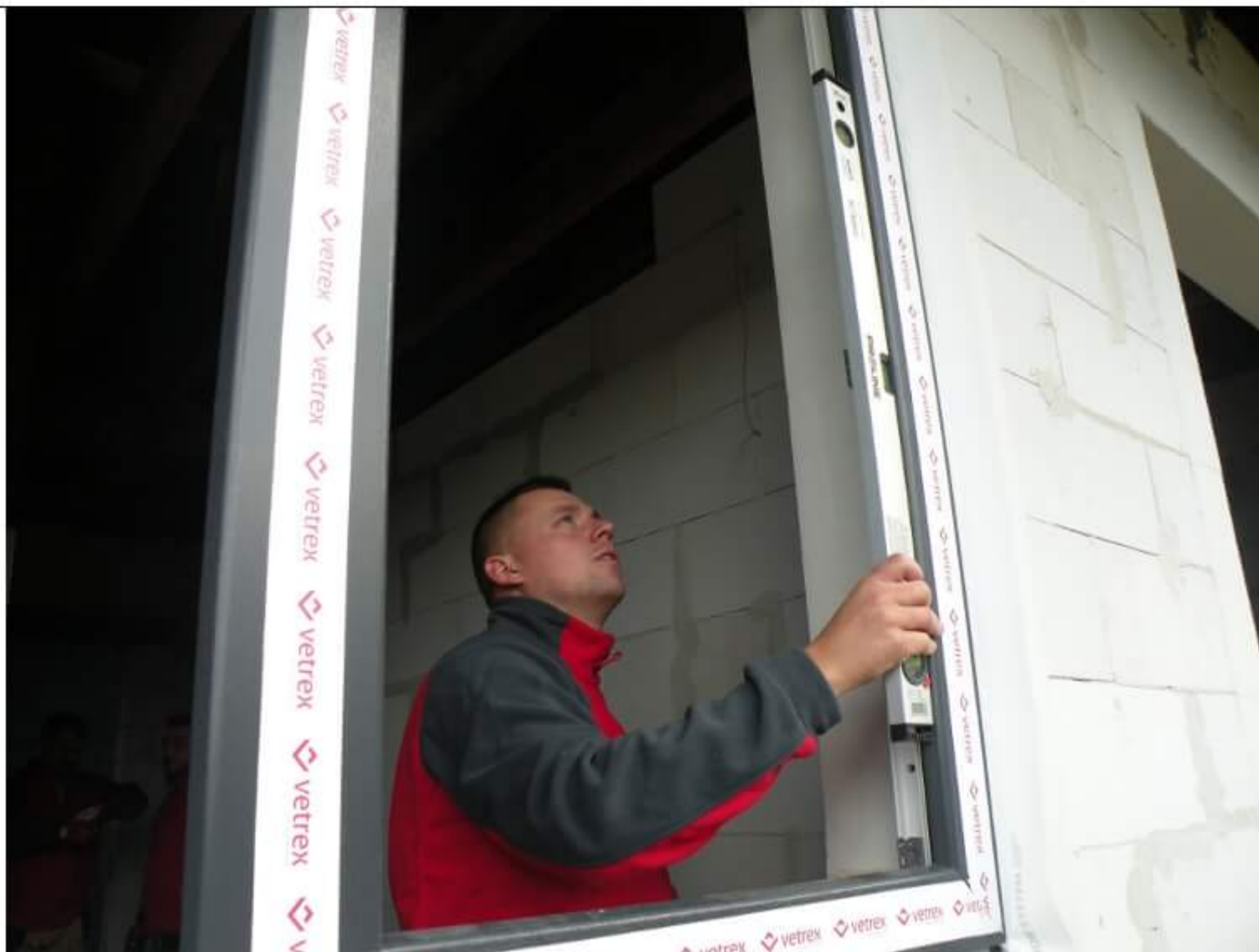
Ciepły montaż okien fot. Vetrex
