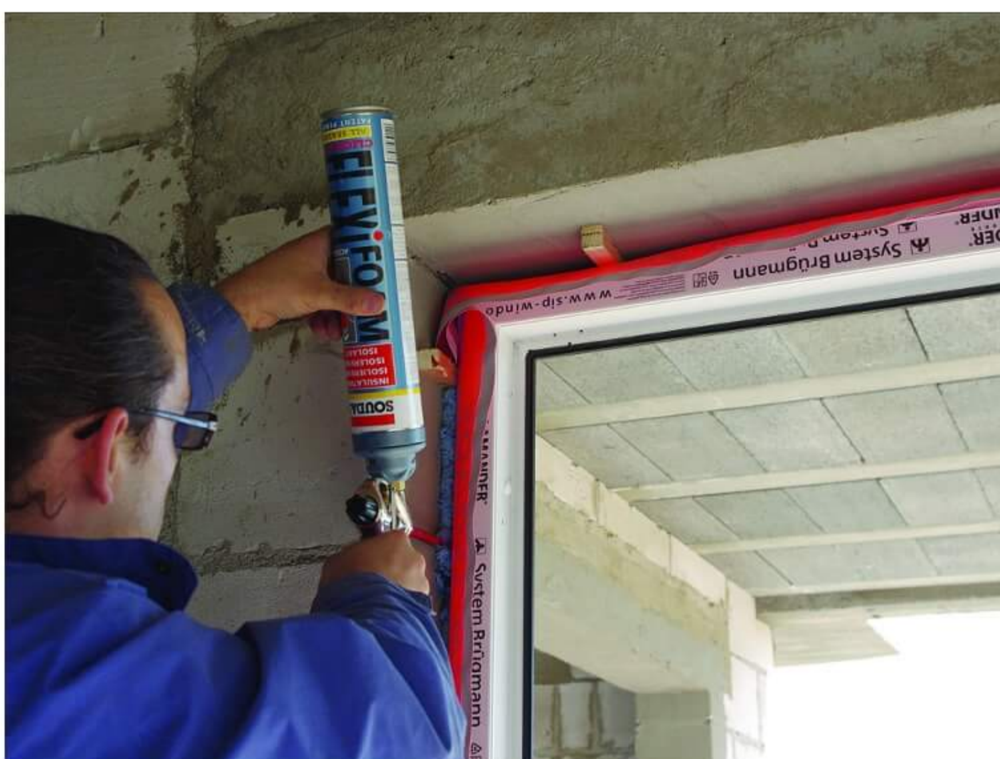
Ciepły montaż okien fot. Soudal
