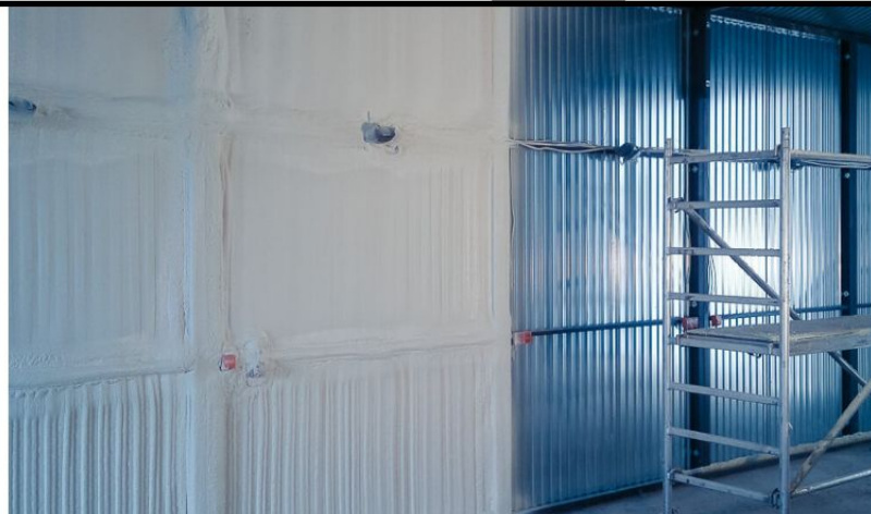
Ocieplenie blaszanego garażu od wewnątrz pianką Soudafoam SPF. fot. Soudal
