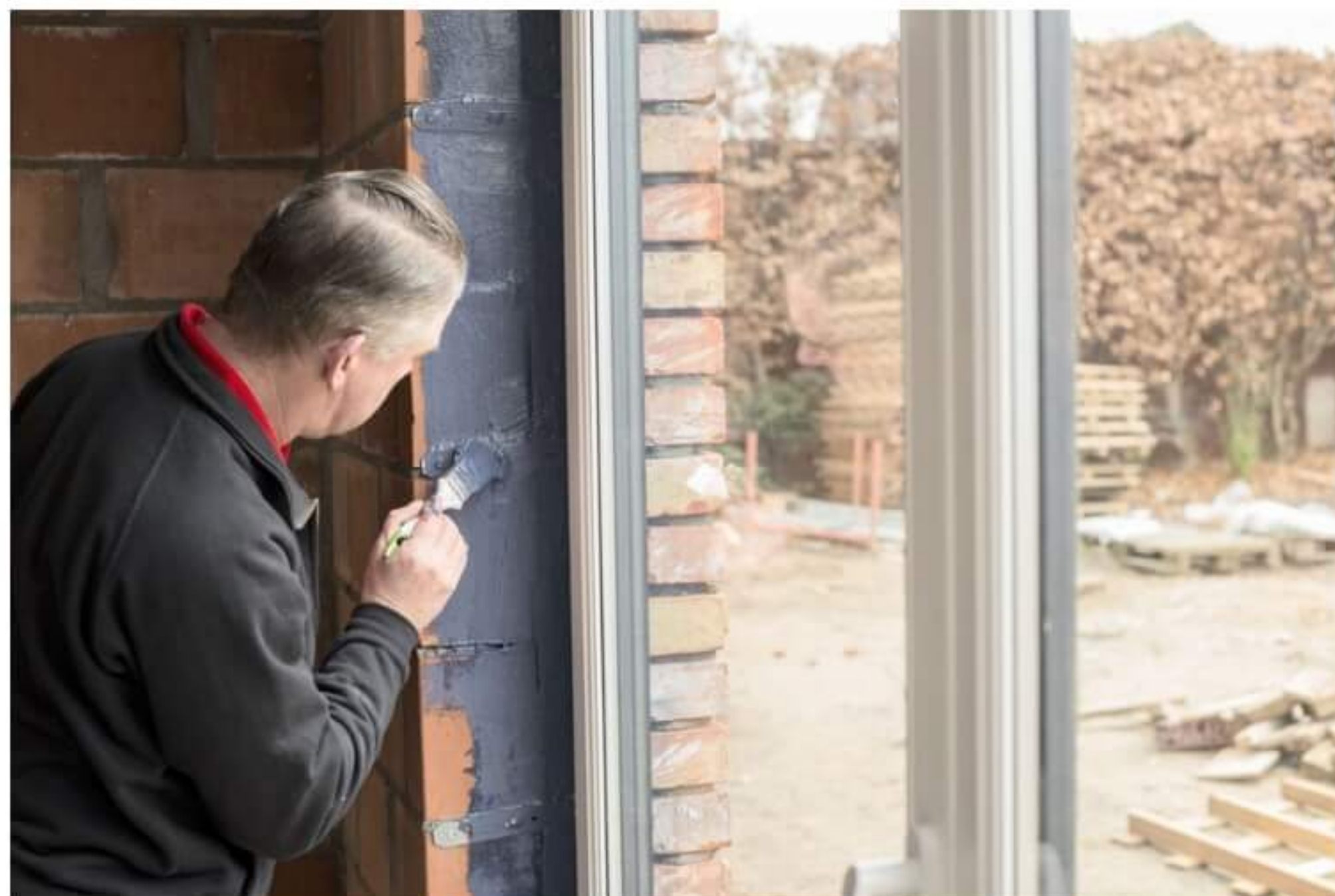
Nakładanie membrany Soudalight LQ wewnątrz pomieszczenia podczas ciepłego montażu okien SWS
