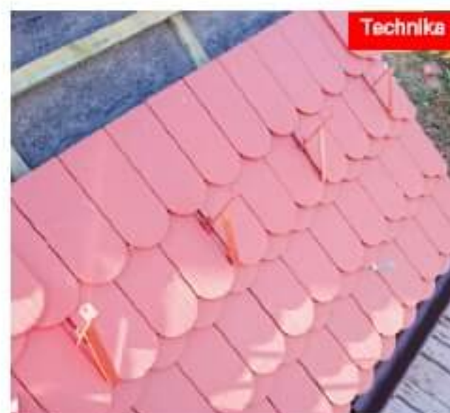
Usuwanie niedoskonałości projektowych pokrycia dachowego poprzez poprawną realizację
