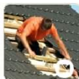
Montaż pierwszego okna dachowego Dakea w Polsce
